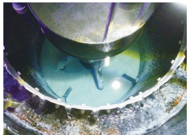
図4 固液分離の様子（運転①）
