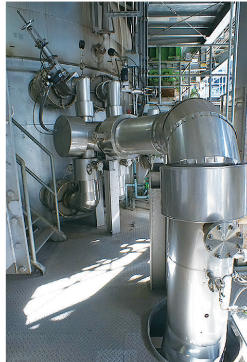
写真2 局所攪拌空気吹込み技術設置状況
